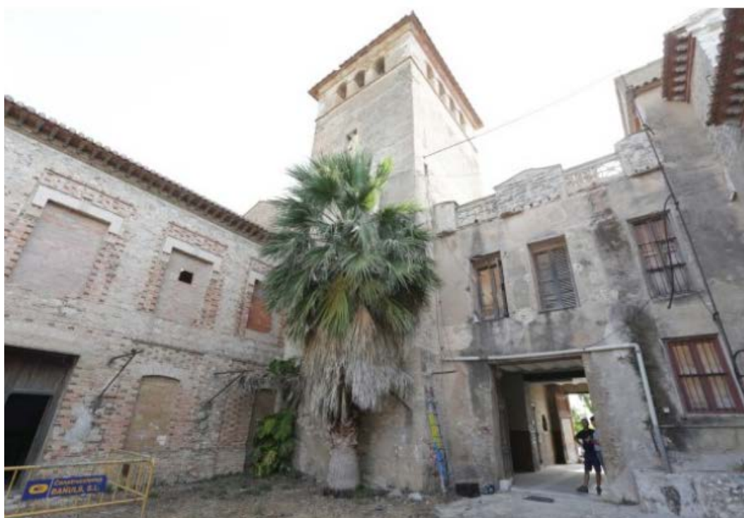
Imagen 2. El mismo edificio, en estado ruinoso, siendo intervenido de urgencia
