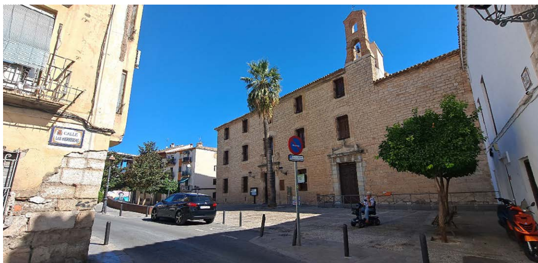
Figura 4. Vista de la fachada del Palacio de Villardompardo, bajo el cual se ubican los restos de los Baños árabes de Jaén.
